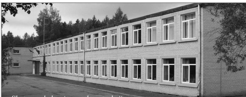
Skats uz skolu pirms rekonstrukcijas
